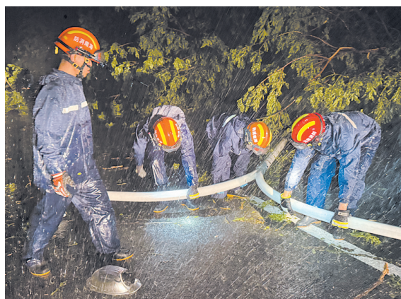
8月24日晚,三亚市消防救援支队组织救援力量连夜开展抢险清障作业,全力保障道路畅通。 通讯员莫文彬 摄
