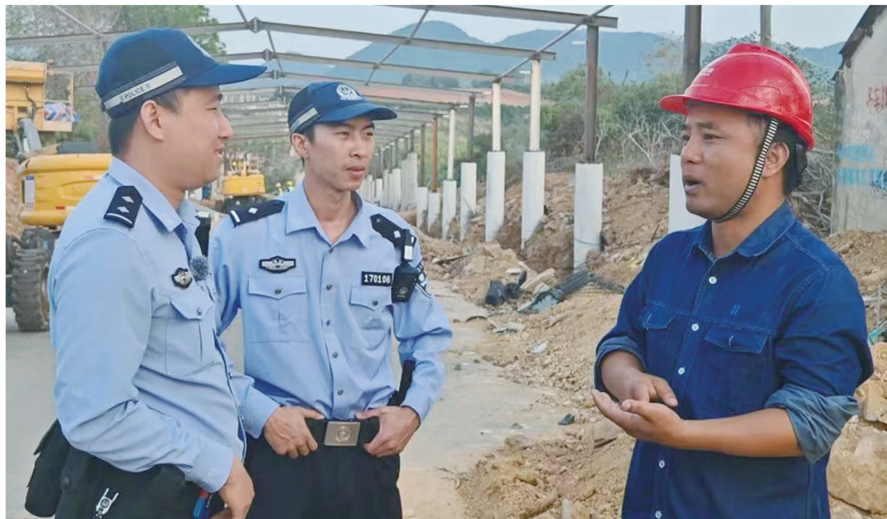
民警在果园施工现场了解情况。(东方市公安局供图)
