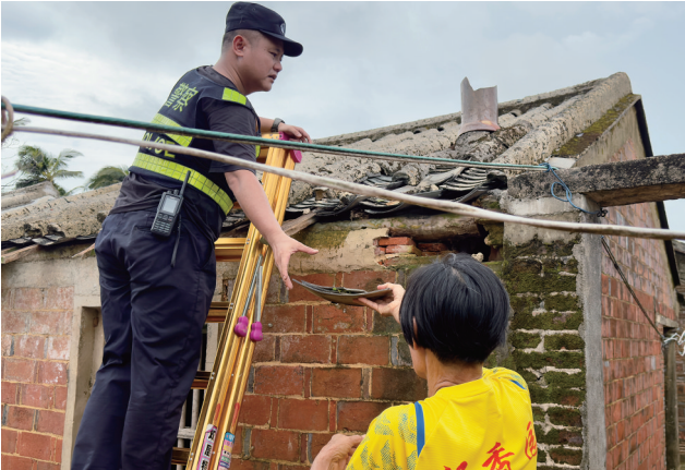
2024年9月8日,支援文昌的三亚藤桥海岸派出所民警为群众修缮被超强台风“摩羯”损坏的房屋。通讯员叶佳 摄
