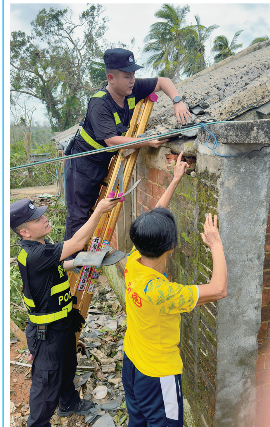
支援文昌的三亚藤桥海岸派出所民警为群众修缮损坏的房屋。通讯员叶佳 摄
