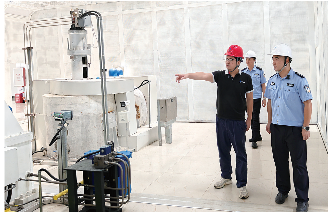
城东派出所民警马明到辖区凯润(东方)新能源有限公司了解安全生产等情况。记者覃创源 摄
